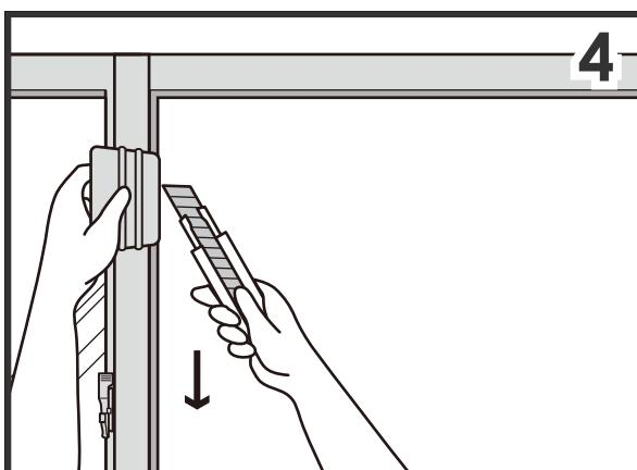
位置決め後、窓枠より大きい部分は定規やへらを使い、カッターでガラスに傷を付けないように切り取ります。
